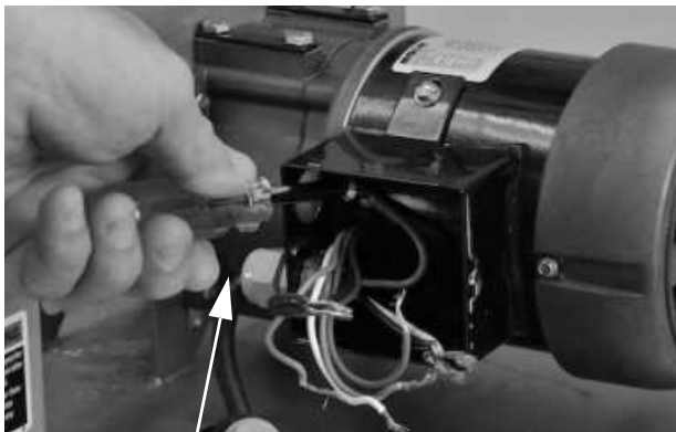
Câble d'alimentation du moteur installé dans l'orifice inférieur de la boîte de jonction
