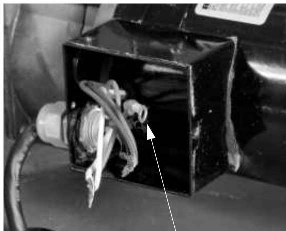
Cable verde de tierra
