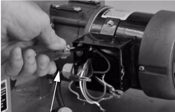
Cordón del motor, instalado en el agujero inferior de la caja de conexiones
