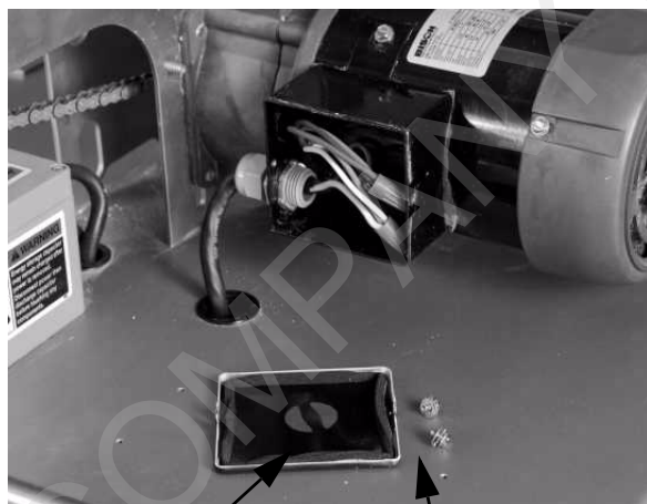
Cubierta de la caja de conexiones
